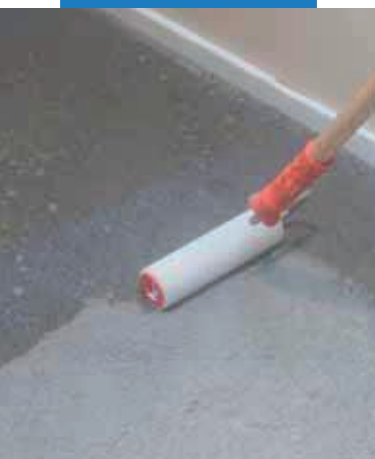
Aplikácia Primeru G pomocou valčeka
