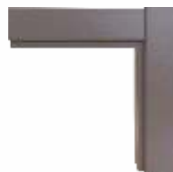
Detail spoje na tupo (zárubeň konstrukce SEPOS)
